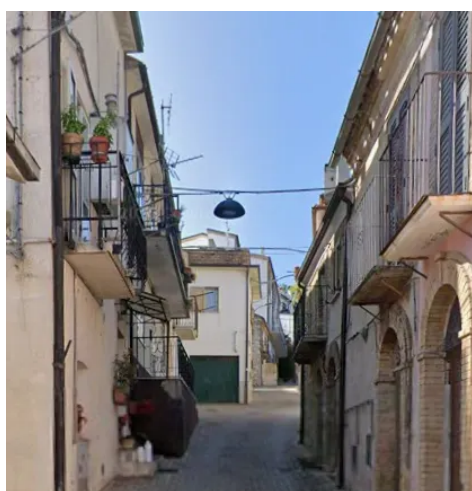
Sospensioni a LED dopo lavori
